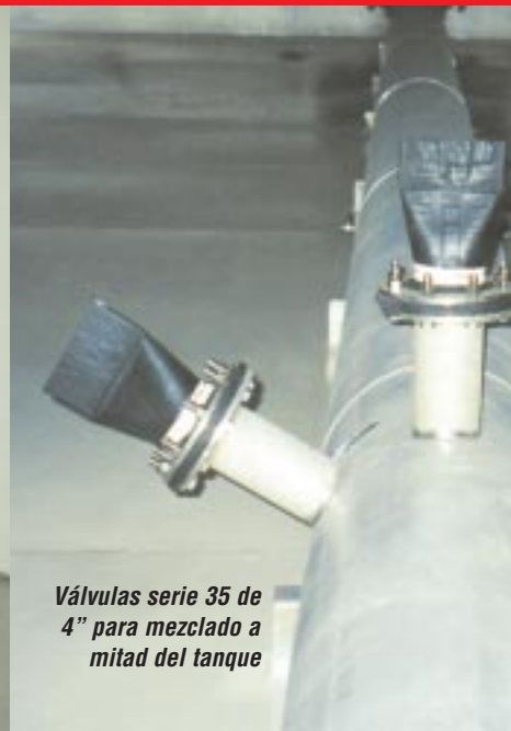
La ciudad de Antioch, California. Tiene instalado un deposito meálico con válvulas serie 35 de 12" para llenado y mezclado
