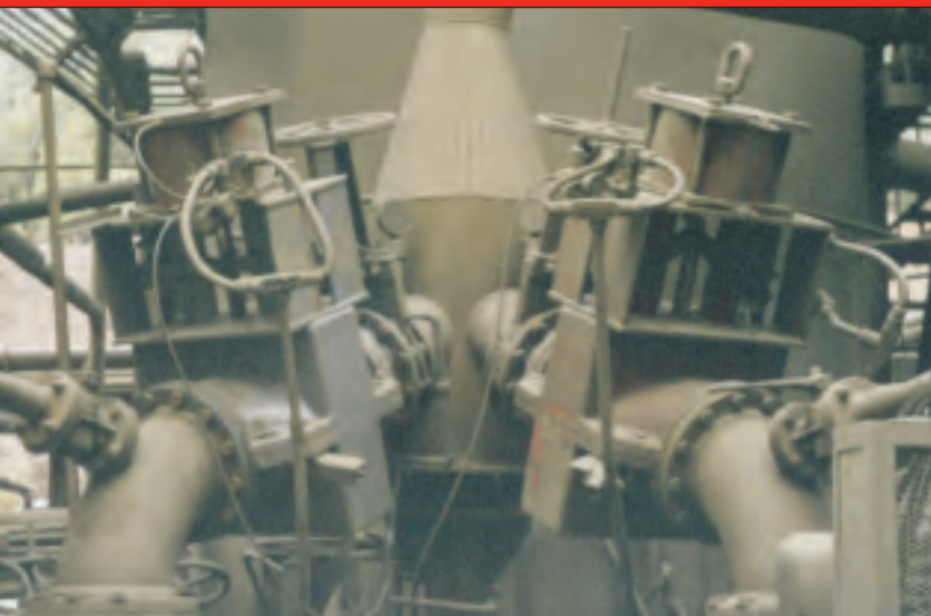
Válvulas de pellizco de control de flujo en un sistema de deshidratación en la planta de filtración de la Mina Codelco.
