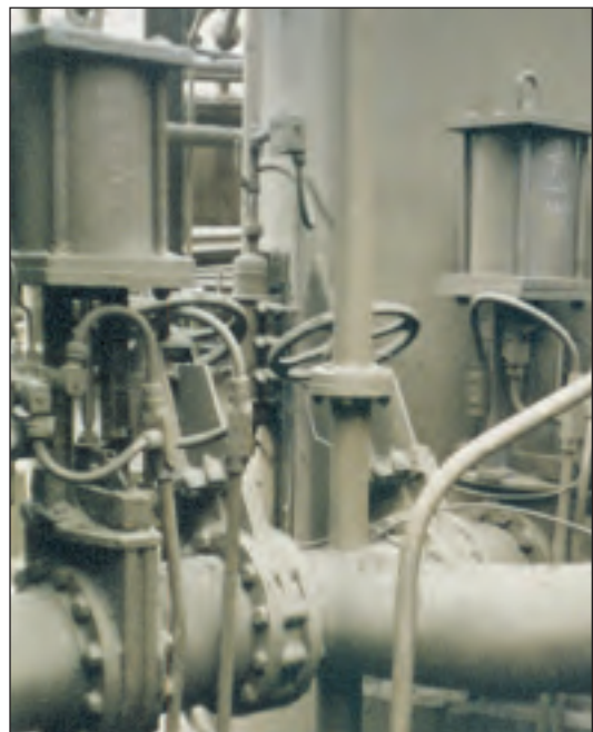
Válvula de aislamiento de tanque en la Mina Andina, Chile
