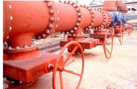
Die Schlauchquetschventile der Serie 70 und 75 mit offenem oder geschlossenem Spindelgehäuse zeichnen sich durch den 100%igen Durchgang bei voll geöffnetem Ventil aus und erzeugen daher keinen Druckabfall.
