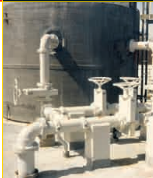
右图：75系列管夹阀在热石灰循环系统中提供可靠的PH值调节。
