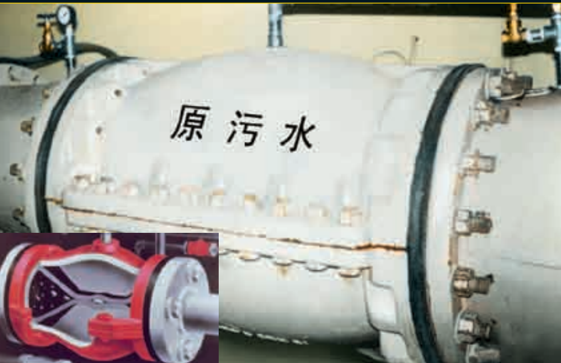
左图：A型管夹阀是唯一一种无需执行机构，对固体介质可以夹紧关断的自动阀门。
