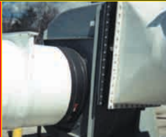
上图：在空气处理系统中，大尺寸方形和圆形管接口。
