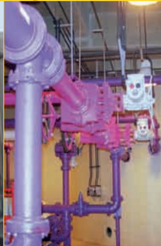
大尺寸手动管夹阀
