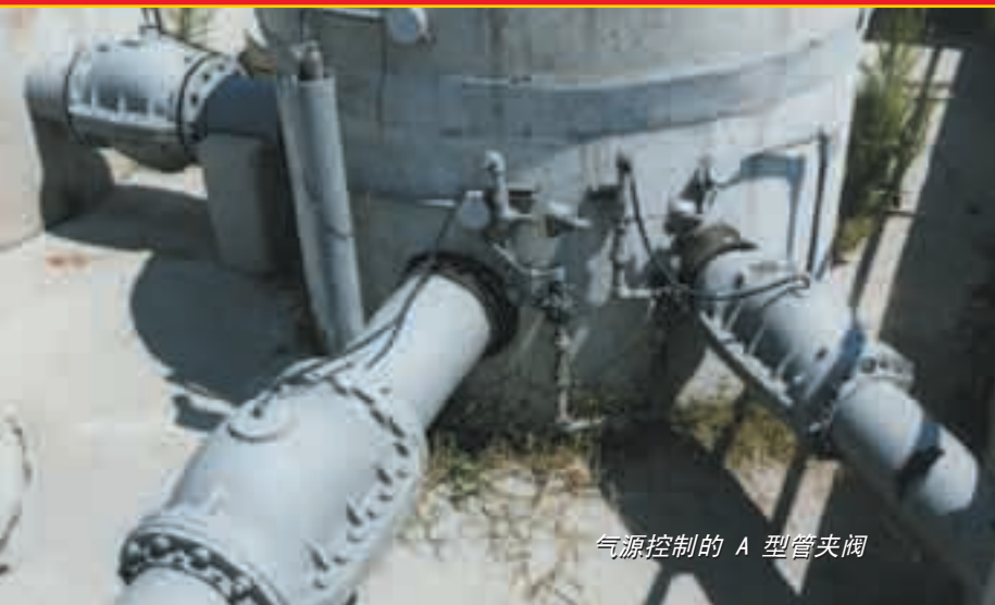
除砂分离室中的75系列管夹阀
