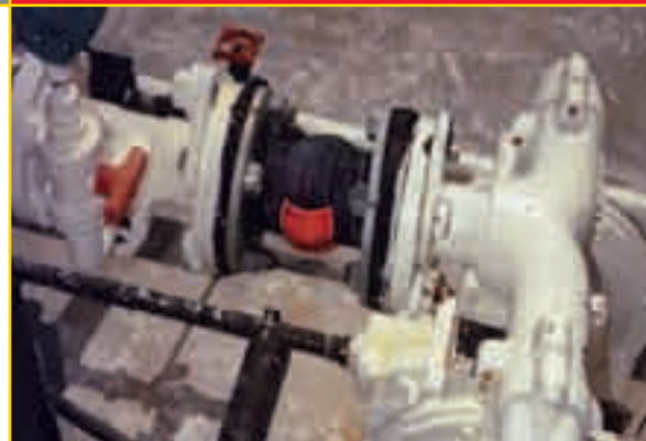
右图：红阀公司J-1伸缩节应用在石灰泵站系统上。
