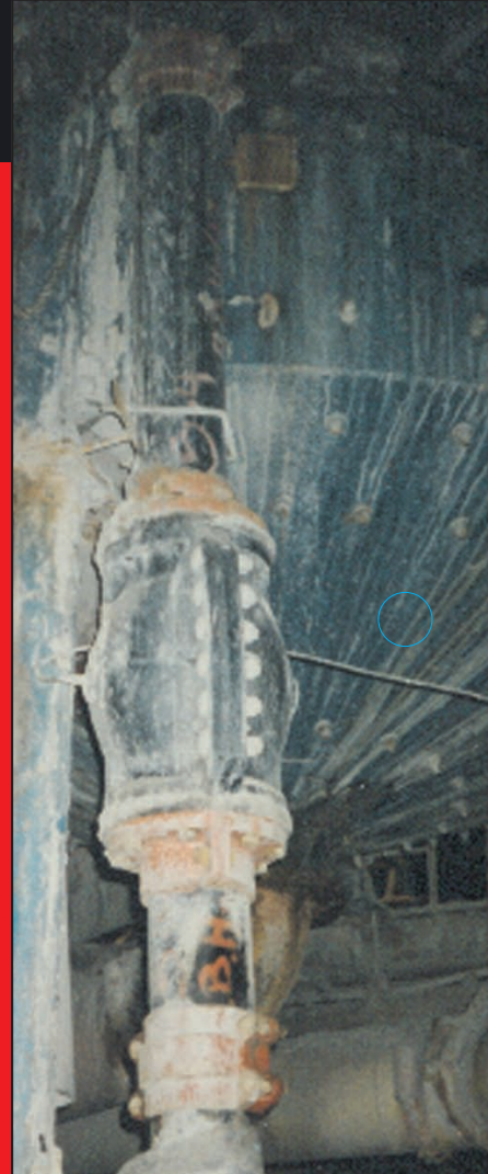
浮选室上，装有锥形套管的液位控制管夹阀(此处采用A型管夹阀)
